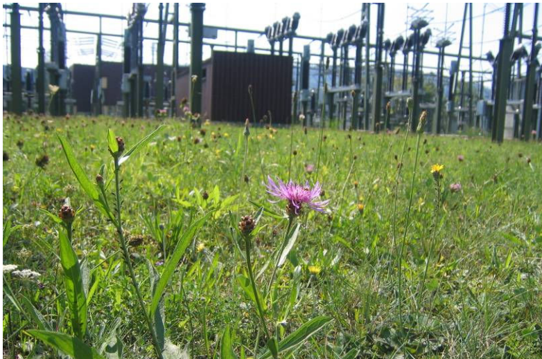
Blumenwiese in einem Unterwerk von ewz
